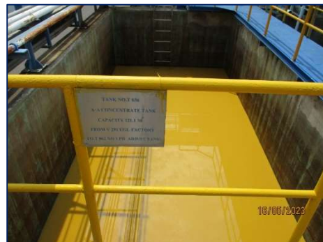
ภาพที่ 2-12 ระบบเก็บกักน้ำเสีย
