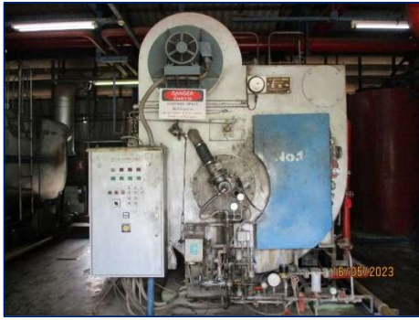
ภาพที่ 2-1 ระบบควบคุมกึ่งอัตโนมัติ เพื่อควบคุมส่วนผสมระหว่างอากาศและน้ำมันที่ Boiler
