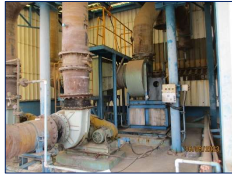
ภาพที่ 2-2 Lamellar Mist Separator
